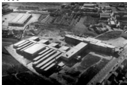
Il Malignani in costruzione
